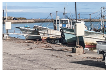
▲ 白子港流木撤去
